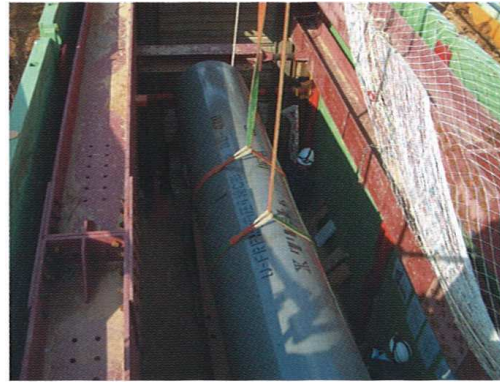
管吊りおろし
